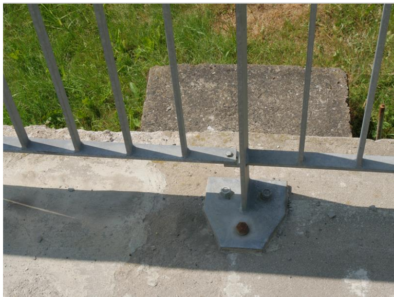
koroze kotevnic šroubů
