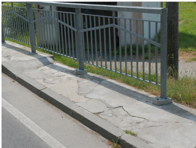
levé předpolí u OP2 - chodník na předpolí je umístěn níže, rozpadlý kerný povrch
