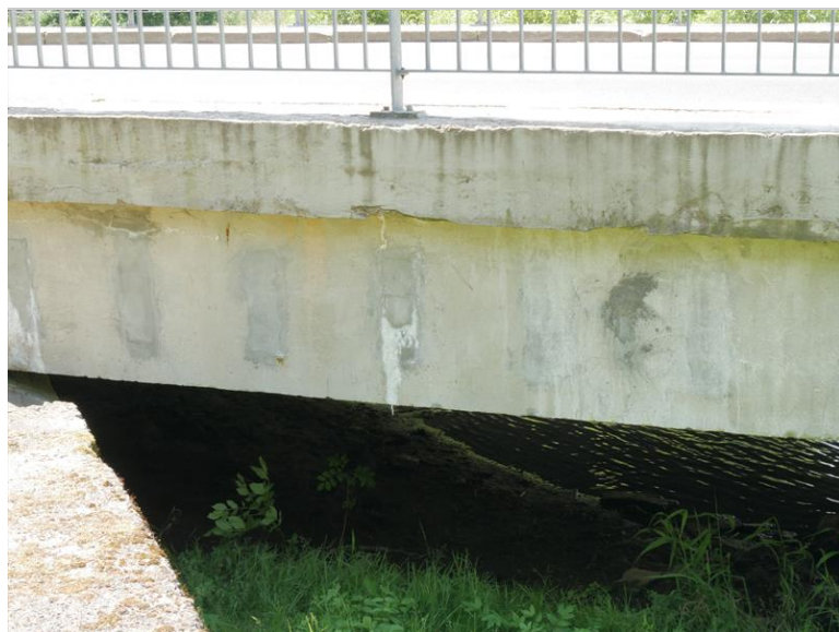
záclonový výluh cementového mléka z kapsy příčného sepětí
