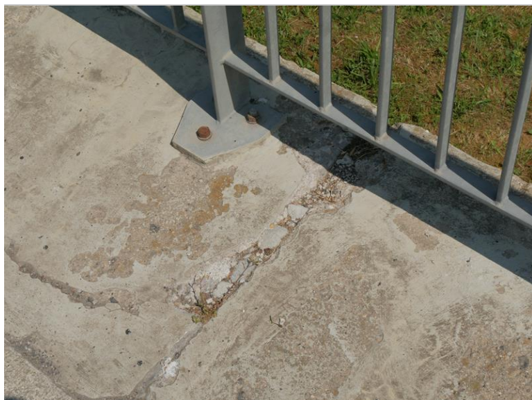
rozpadlý beton v místě dilatační spáry v římse
