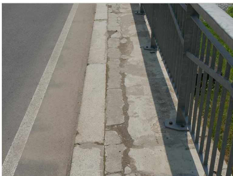
degradace betonu dobetonávky římsy
