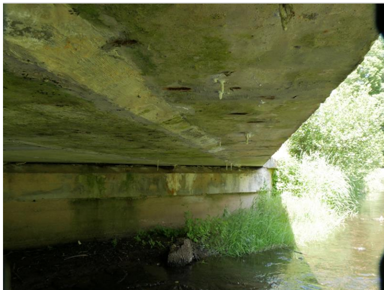
podhled NK - krápníkové výluhy cementového mléka z podhledu NK
