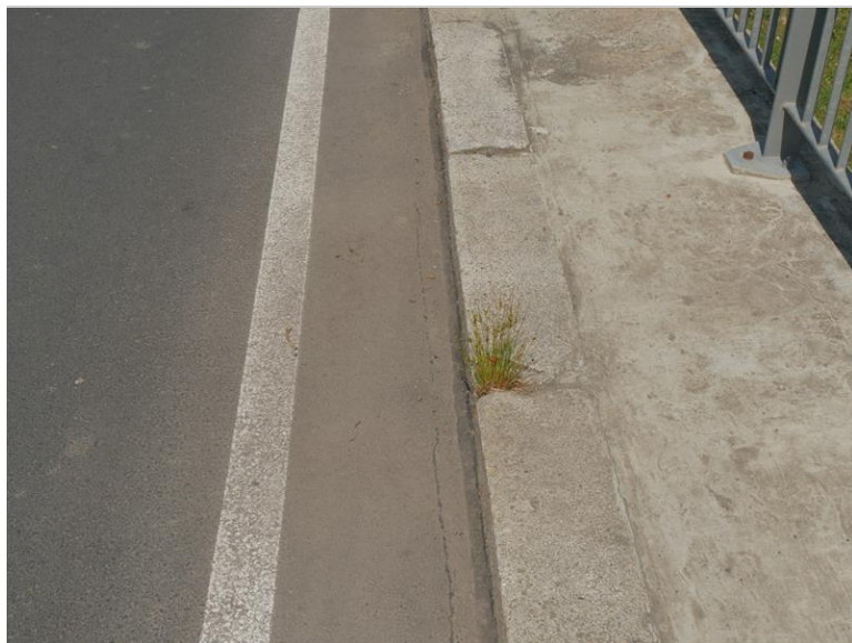
uchycená vegetace ve spárách mezi kamennými obrubníky
