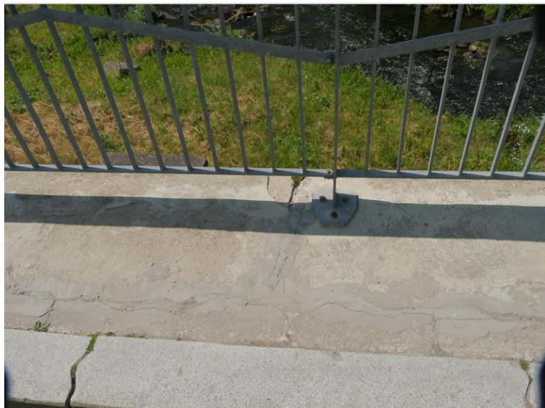
pokus o opravu trhlin v pochozí části římsy
