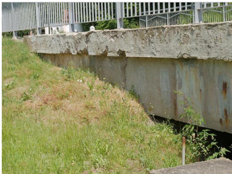
levé křídlo OP2 - rozpad betonu římsy
