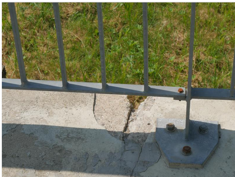
degradace betonu římsy vlevo
