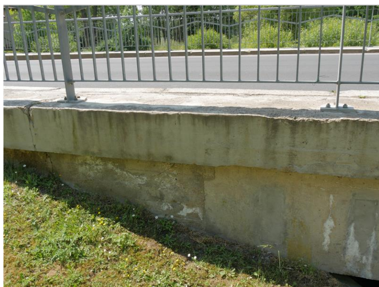
lokální rozpad betonu římsy na křídlem OP1
