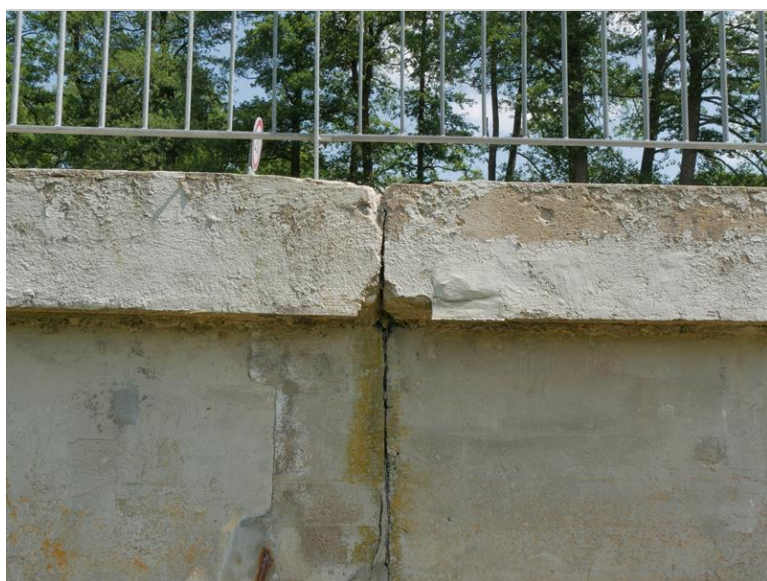
nezatěsněná spára NK x křídlo
