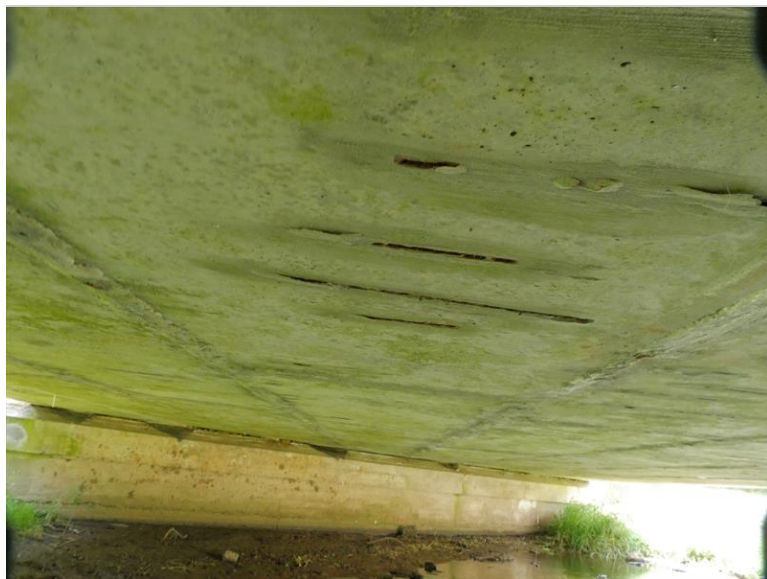
podhled NK - lokální obnažená třmínková výztuž
