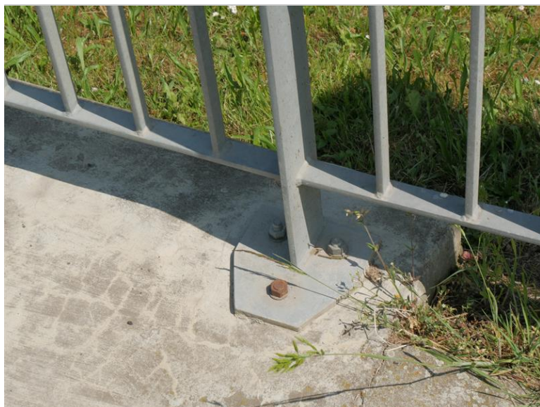
koroze kotevních šroubů zábradlí
