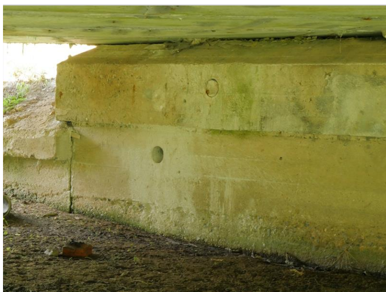
vývrt v OP2 - diagnostika mostu
