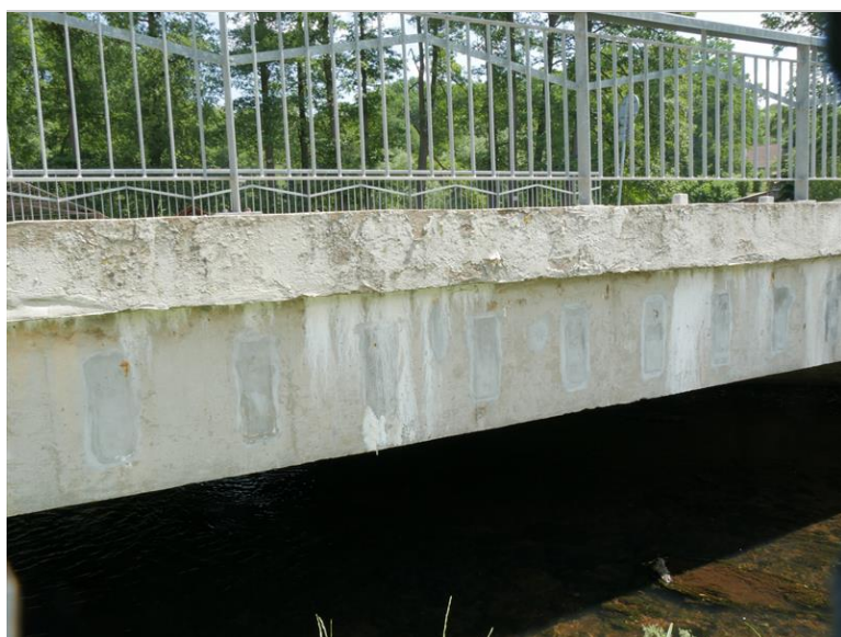
koroze betonu levé římsy
